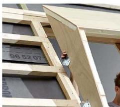
**2 Element za ugradnju krovnog prozora, bočni dijelovi**
